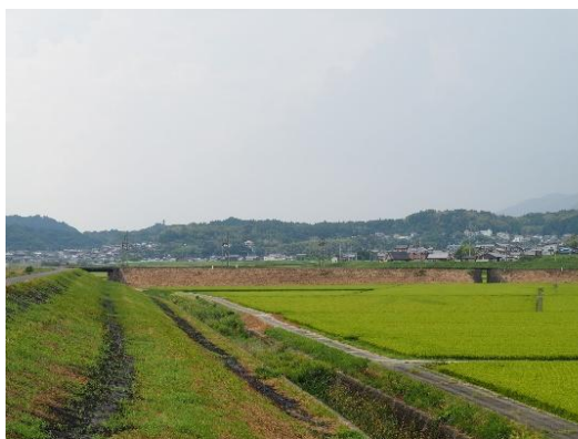
左が服部川の堤防、正面が遊水地の堤防
