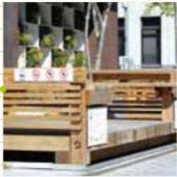
案内看板の取り付け
