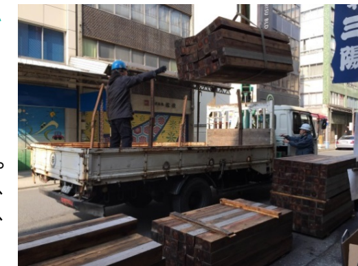
▲錦二丁目では使用する木材を地域の森林より直接搬送
