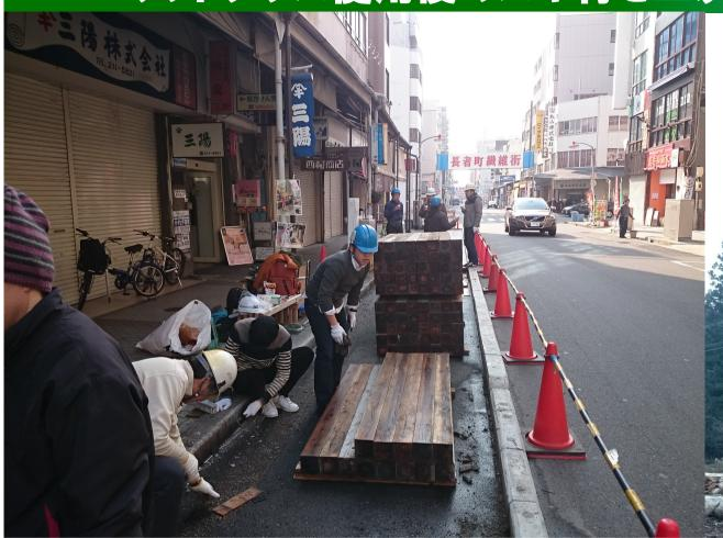
2014年の歩道拡幅社会実験で使用・撤去後、保 管していたスギ材を,新しいストリート・ウッド・デ ッキ用材として二次利用します.
